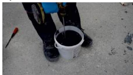
Протекающие реакции идут с выделением тепла, поэтому смесь саморазогревается в объеме (ведре) материала и процесс полимеризации ускоряется. Из этого следует, что время жизни материала в объеме и на поверхности значительно отличается и простой в ведре существенно ограничивает время на обработку материала.
