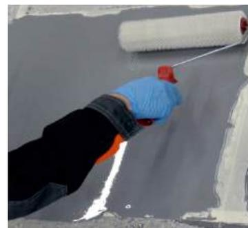
В процессе распределения материала необходимо контролировать состояние лезвия с зубцами. В случае его истирания необходимо заменить на новое, во избежание изменения предполагаемого слоя. Нанесение материала удобнее начинать от стены, противоположной к выходу из помещения. После распределения материал следует прокатать с помощью игольчатого (деаэрационного) валика. Это позволяет облегчить выход воздуха и процесс растекания материала по поверхности.
