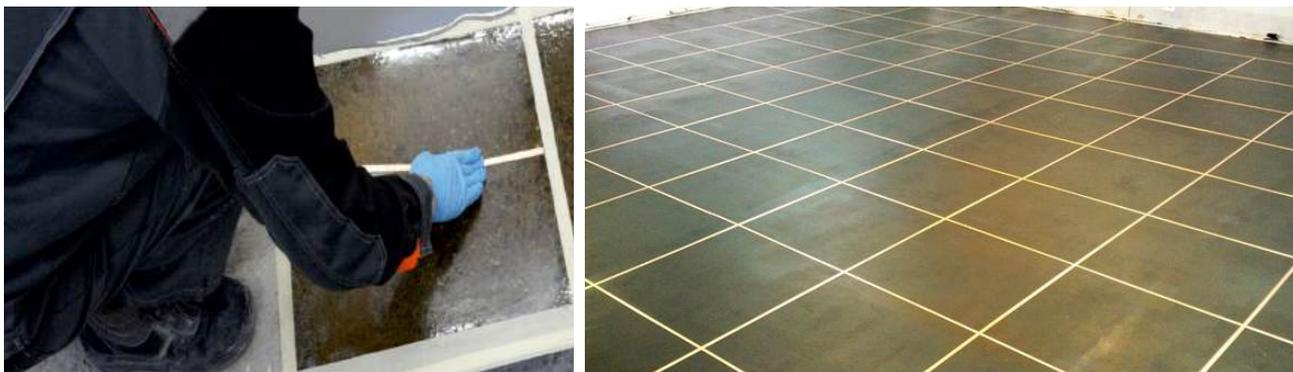
Самоклеящуюся медную ленту необходимо клеить по оштукатуренной поверхности после окончания процесса полимеризации грунтовочного состава PRASPAN® EP-P150. Лента клеится по контуру помещения (на расстоянии не более 0,1 м от стены или края помещения) и далее по поверхности с шагом (клетками) 1,5–3,0 м (в зависимости от конфигурации помещения).
